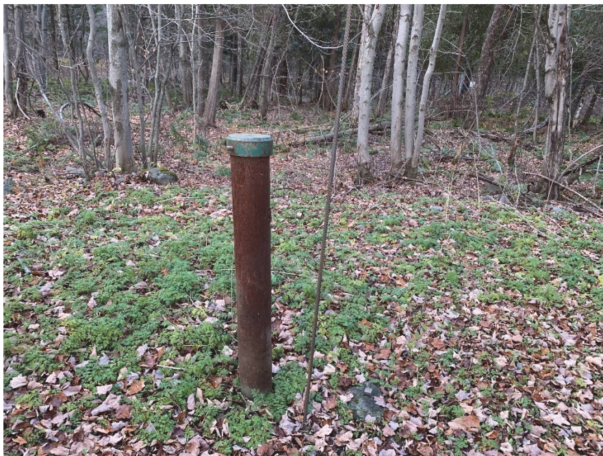
9. Vue du regard donnant accès au PZ-3 – 2024-11-08
