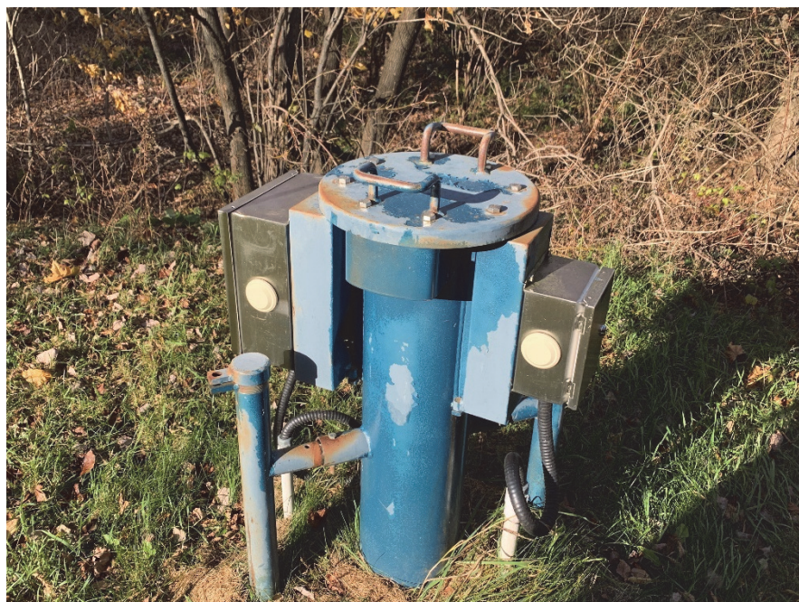
14. Vue du regard donnant accès au puits PE-4 – 2024-11-08
