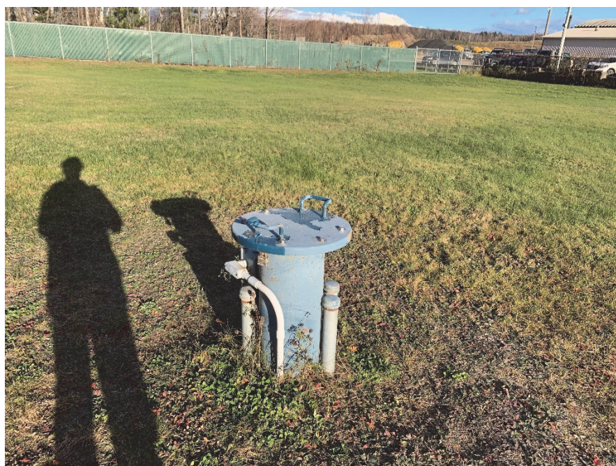
24. Vue du regard donnant accès au puits PE-6 – 2024-11-08
