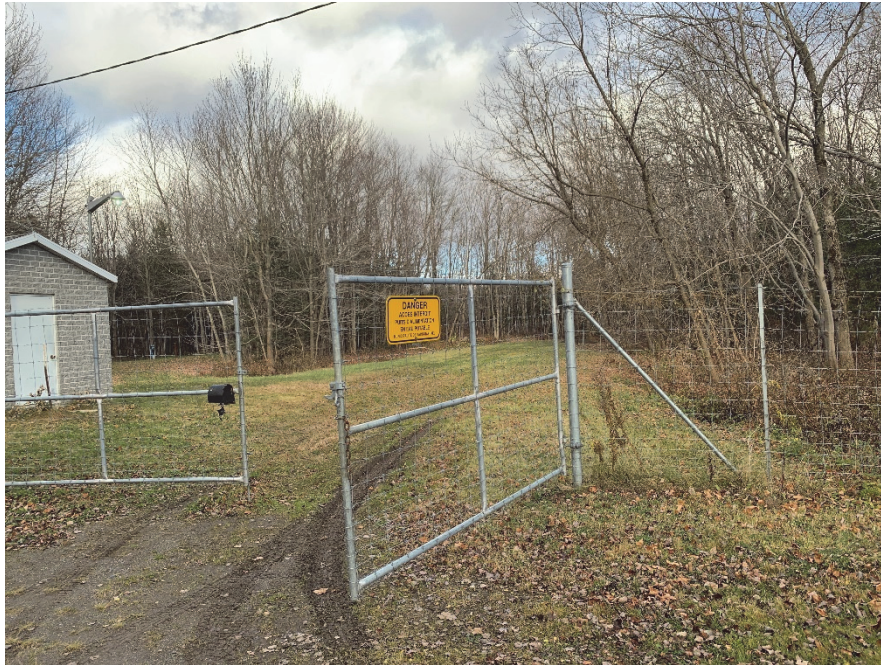
1. Accès aux puits PE-1, PE-2 et PE-3 ainsi que l'installation de pompage – 2024-11-08
