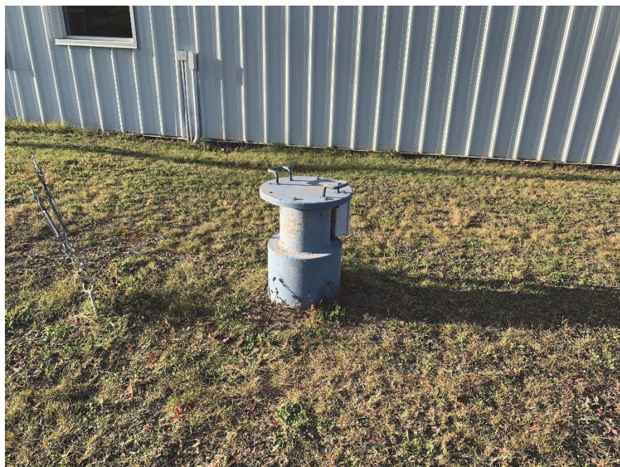
23. Vue du regard donnant accès au puits PE-5 – 2024-11-08
