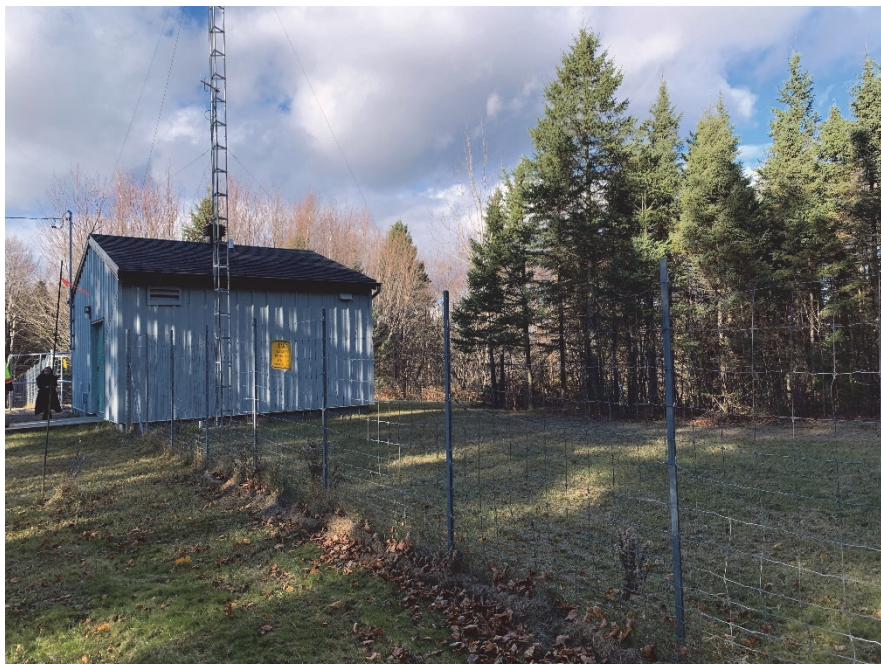
19. Vue extérieure de la station de pompage et traitement du site PE-4 – 2024-11-08
