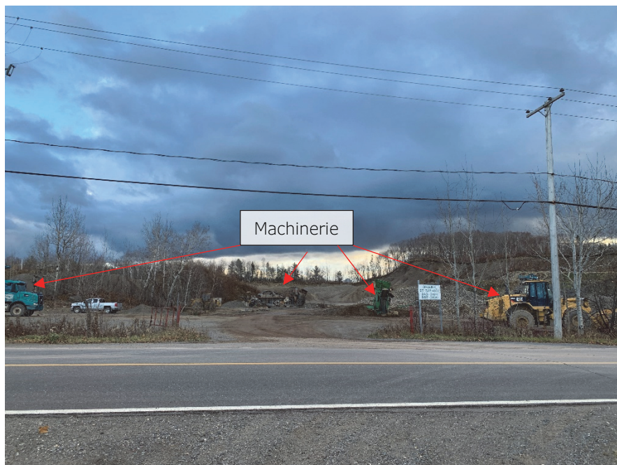
35. Vue de la gravière Saint-Raphaël qui se trouve en amont hydraulique du site des puits PE-1, PE-2 et PE-3 – 2024-11-08
