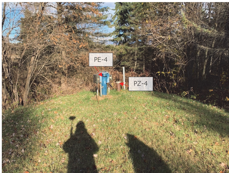
13. Vue générale du site du puits PE-4 et PZ-4 – 2024-11-08
