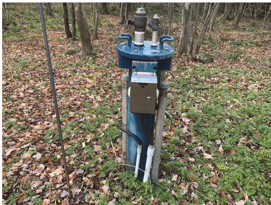
8. Vue du regard donnant accès au puits PE-3 – 2024-11-08
