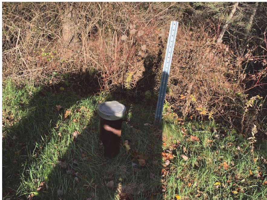
15. Vue du regard donnant accès au PZ-4 – 2024-11-08
