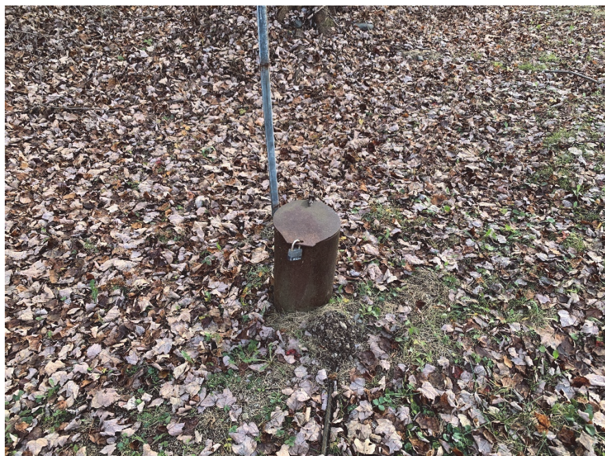
4. Vue du regard donnant accès au PZ-1 – 2024-11-08
