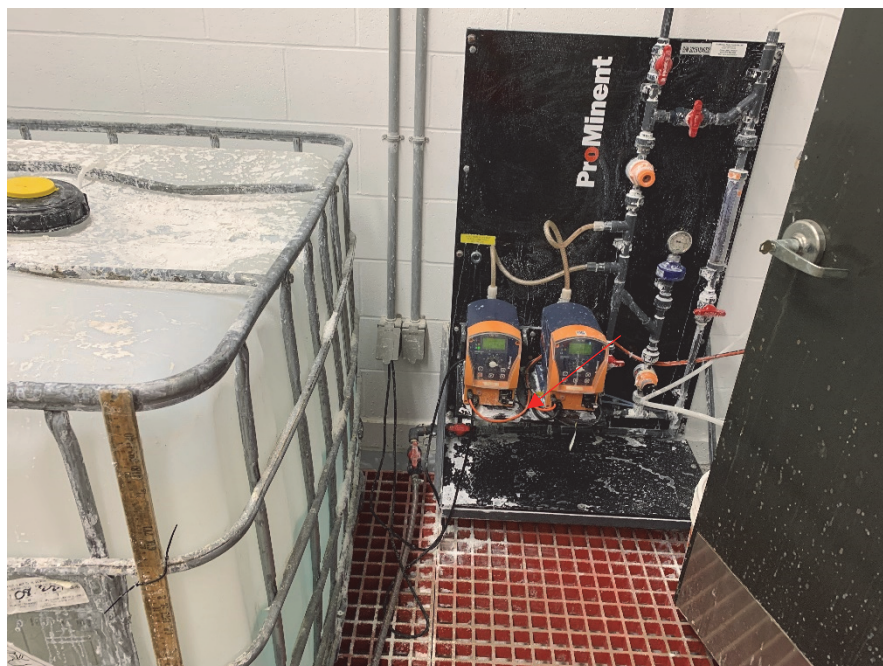
31. Système de dosage de la soude caustique – 2024-11-08
