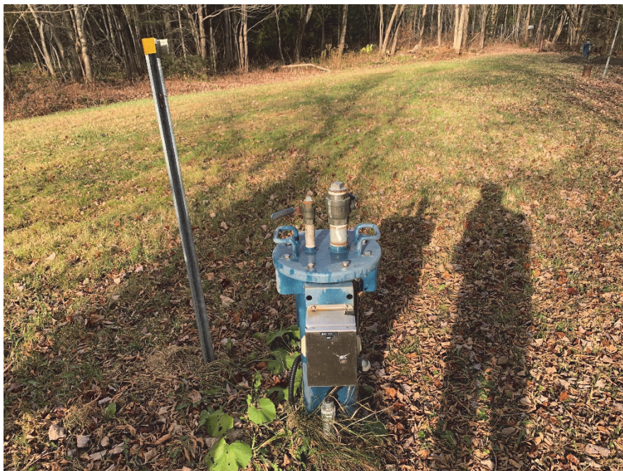
3. Vue du regard donnant accès au puits PE-1 – 2024-11-08
