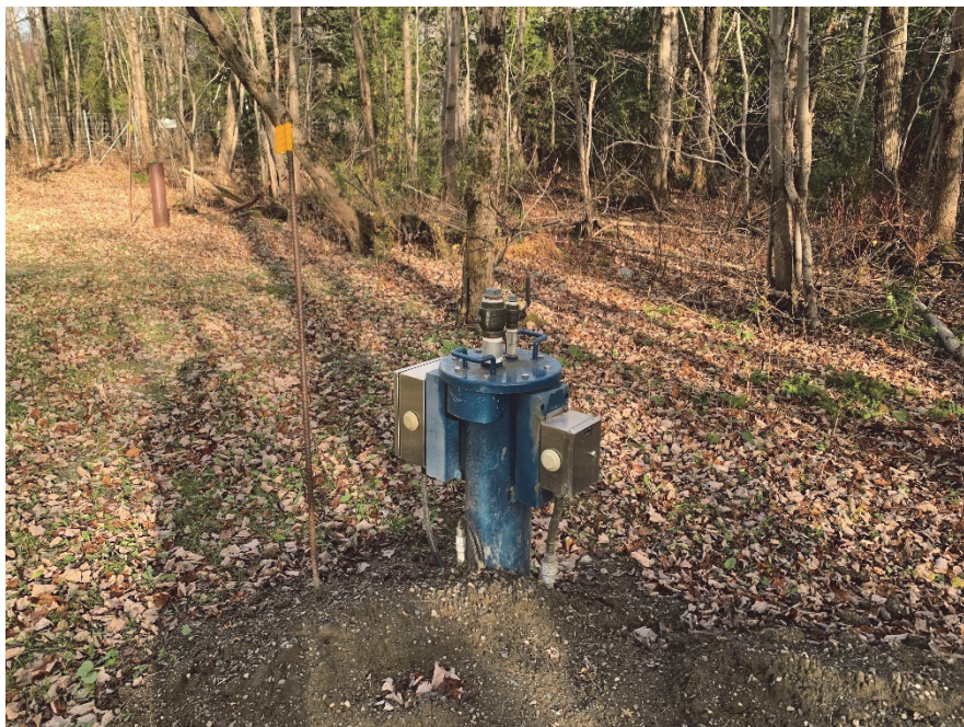
5. Vue du regard donnant accès au puits PE-2 – 2024-11-08
