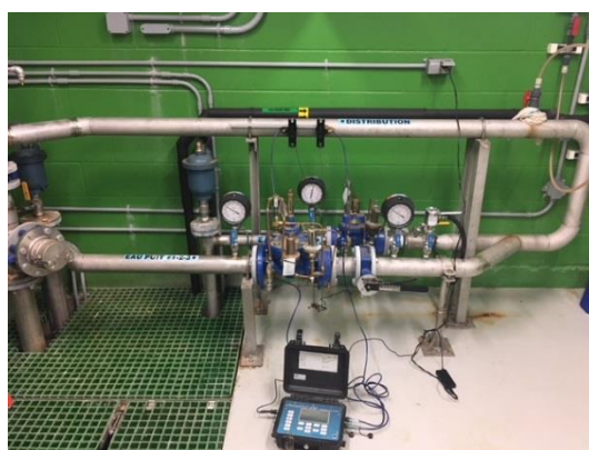
Figure 7. Montage de l'équipement étalon pour la vérification des débitmètres des puits 1-2-3 et 4
