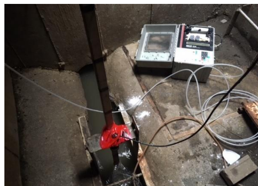
Figure 11. Installation de l'équipement étalon pour la vérification de la sonde à niveau du canal Palmer Bowlus
